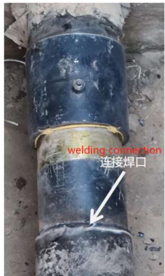
图 3 注胶式接头，接头芯子与短节焊接连通。
