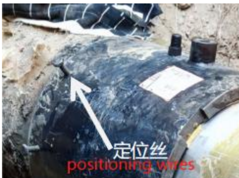
图 1 注胶式接头，使用定位丝定位，接头与旧管道无连接。
