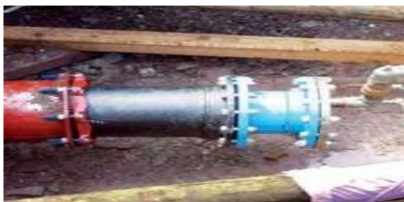
管内衬修复技术原理 Inserted Hoses - IH Technology
