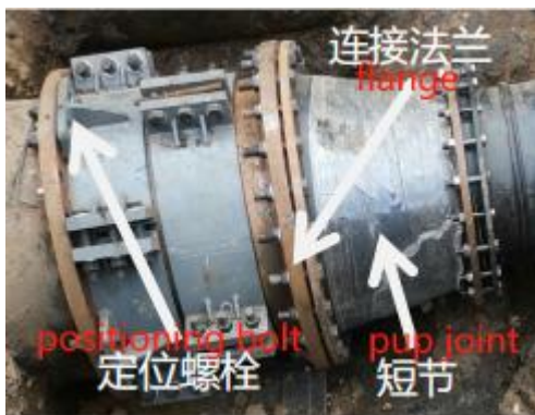
图 2 夹具式接头，使用定位螺栓定位，与旧管道无连接，接头芯子与短节法兰连通。
